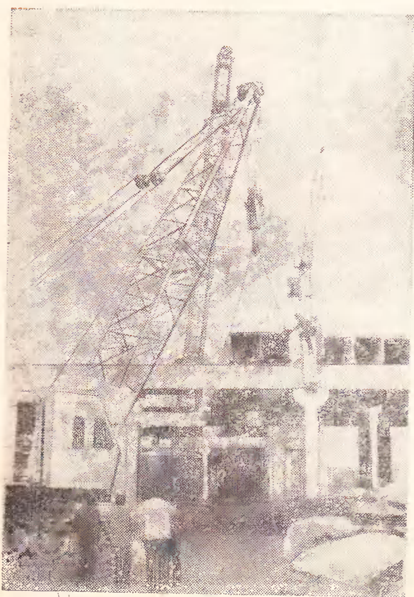
Рис. 3. Монтаж коробчатого настила
